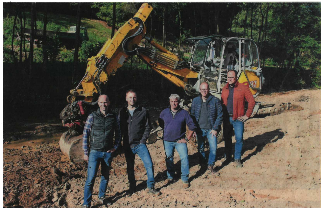
Ralf Badtke (v.li., Projektreferent chance7), Christoph Rothenwöhrer (Leiter chance7), Timo Becker (Baggerfahrer) sowie Falco Hartmann und Dirk Wölfel (Planungsbüro Hartmann) vor einen Schreitbagger im frisch renaturierten Bachbett des Krabachs.
