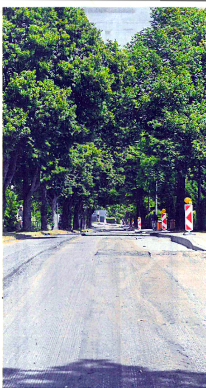
Der Belag für den zweiten Bauabschnitt ist abgefräst: Passage der Landesstraße 289 kurz hinter Herkenrath. Foto: Christopher Arlinghaus
