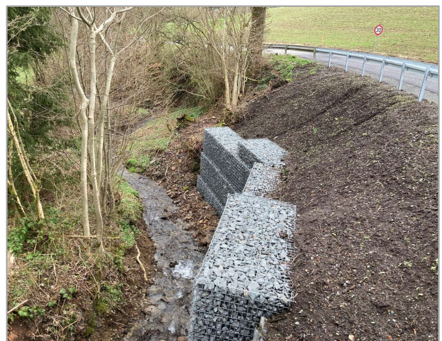
Beispiel für eine Sicherung mittels Gabionen
