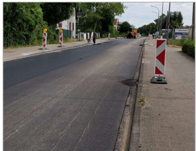
Nach der Deckensanierung
