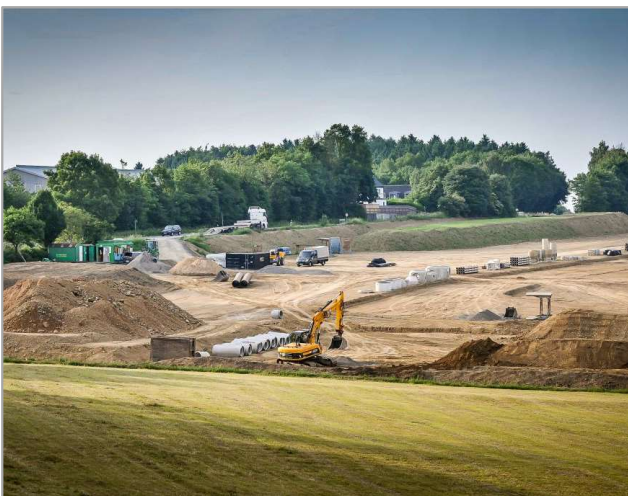
Kanalarbeiten im Grundausbau
