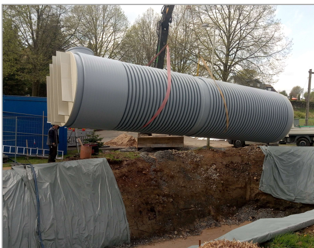
Verlegung Löschwasserbehälter
