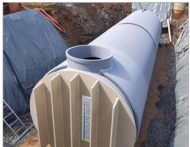
Löschwasserbehälter 50m 3 vor dem Verfüllen
