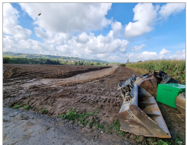
Sicht übers Baufeld
