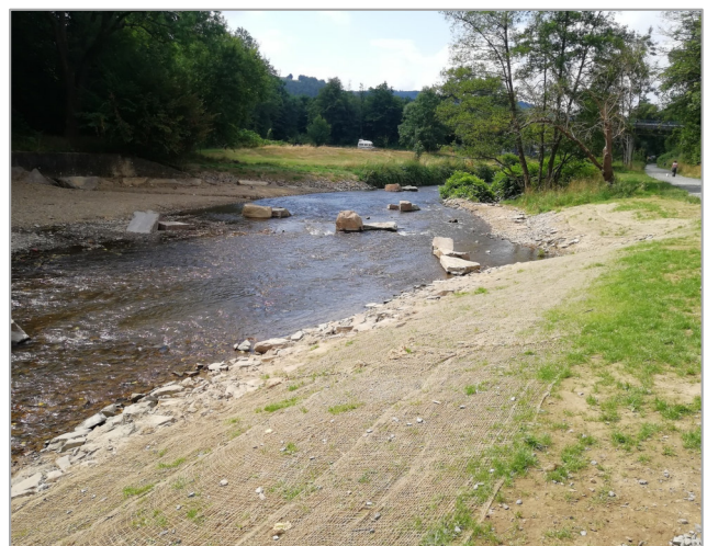
Zustand nach erfolgtem Rückbau
