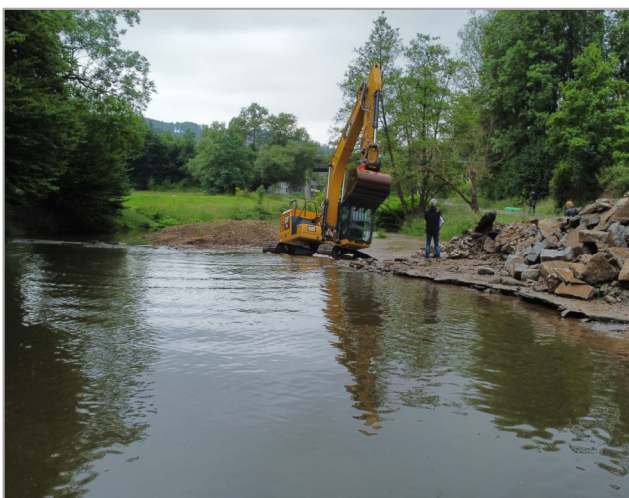
Rückbau der Wehranlage
